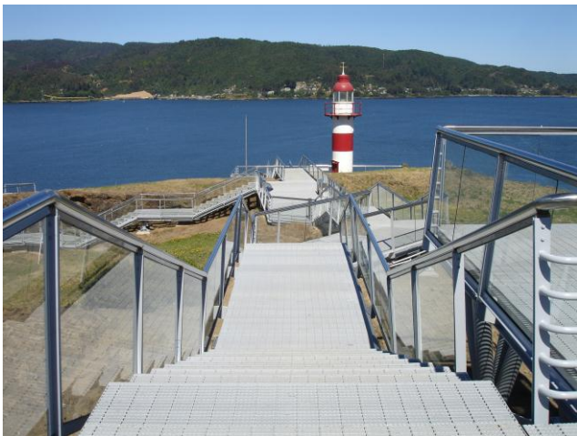
Obra terminada_Castillo de Niebla, Valdivia.
