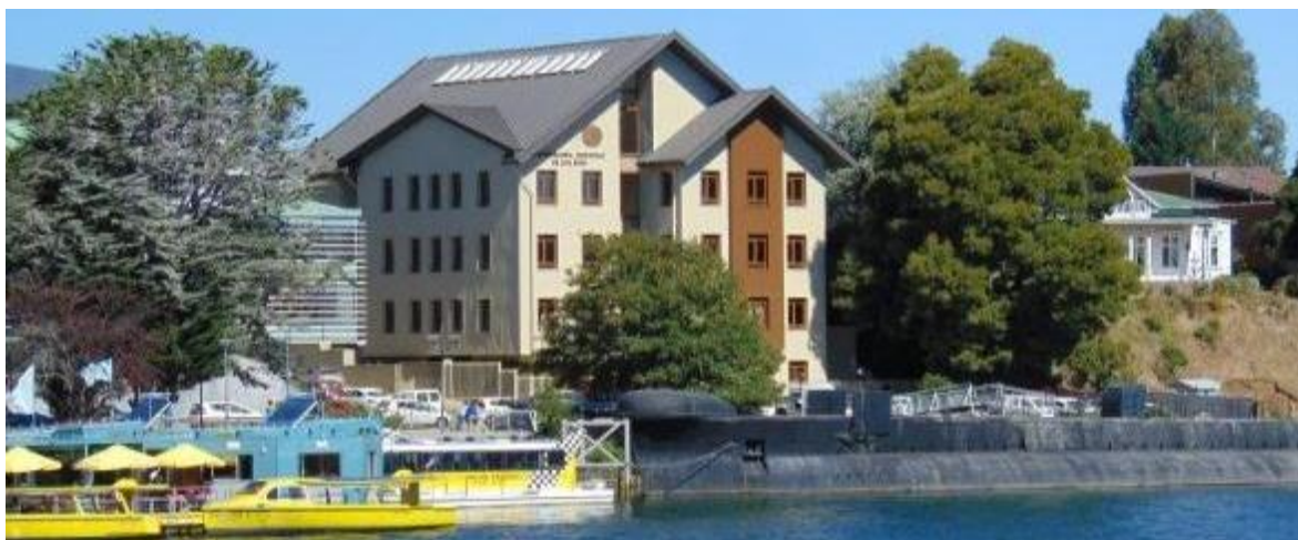
Nuevo edificio de la Contraloría regional en Valdivia entregado año 2014
